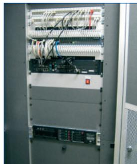
Für die Befestigung in 19" Schalt- und Netzwerkschränken sind die IT-19"-Steckdosenleisten mit speziellen 19"-Endkappen ausgestattet.
